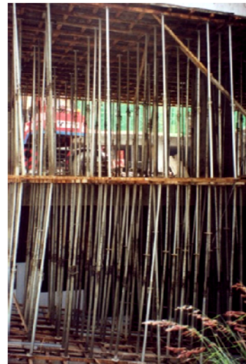
照片 2 工地可調鋼管雙層組搭情形
