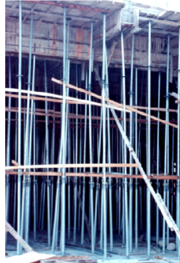
照片 1 工地可調鋼管單層組搭情形
