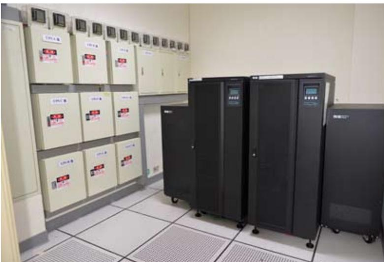
東海大學電算中心機房裝設了智慧電錶，各別監控機臺的耗電情形。
